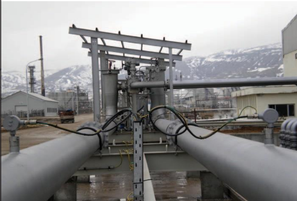
Двунаправленный шарик калибратора
